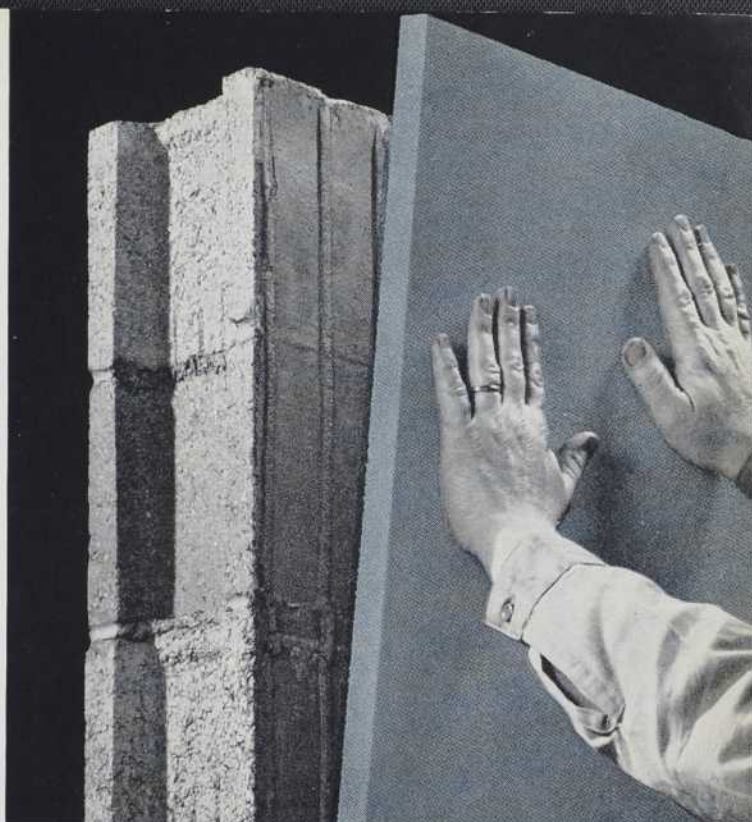
3. Pressez le panneau Styrofoam FR en place.
