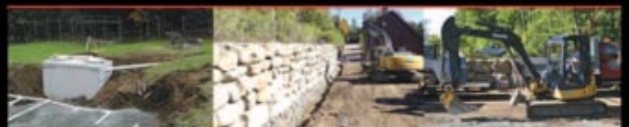
INSTALLATION DE FOSSE SEPTIQUE
