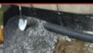
RÉPARATION DE DRAIN FRANÇAIS
