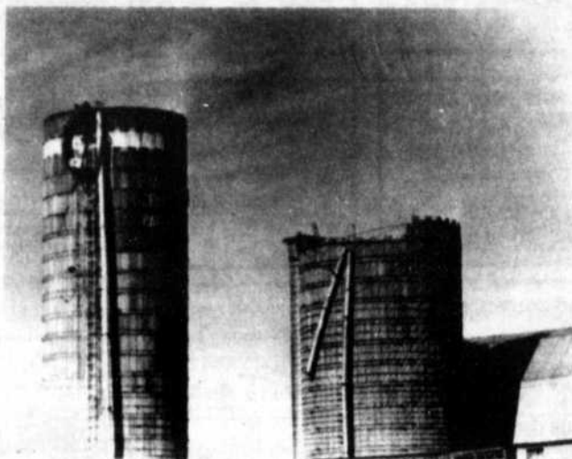
Deux silos décapités à Nicolet-Sud.
