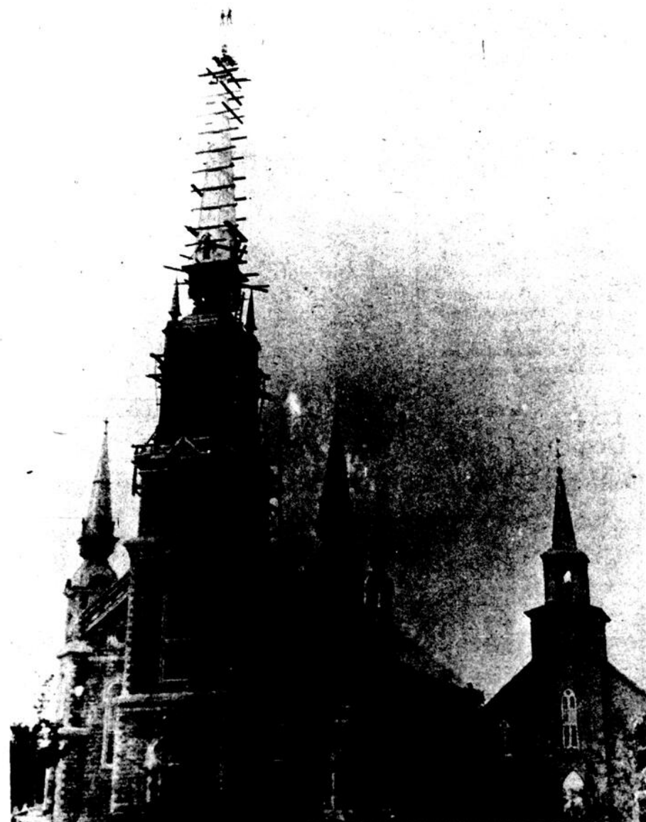
L'église Sainte-Victoire de Victoriaville presque terminée. On remarquera les deux hommes au sommet du clocher, sur les bras de la croix.
