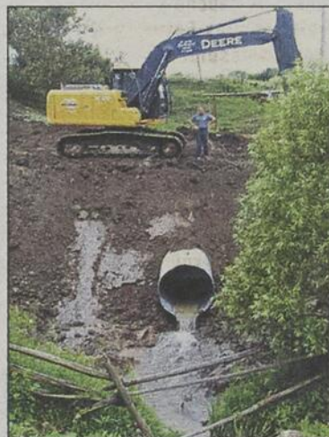
L'installation d'un nouveau ponceau a permis de réduire l'apport de sédiments dans le ruisseau Benjamin.
