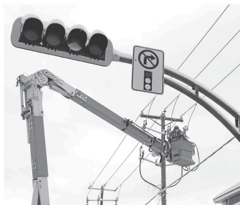
Plusieurs foyers de la région ont été privés d'électricité cette semaine, à la suite de la tempête qui a frappé l'Outaouais. — PATRICK WOODBURY, LE DROIT
