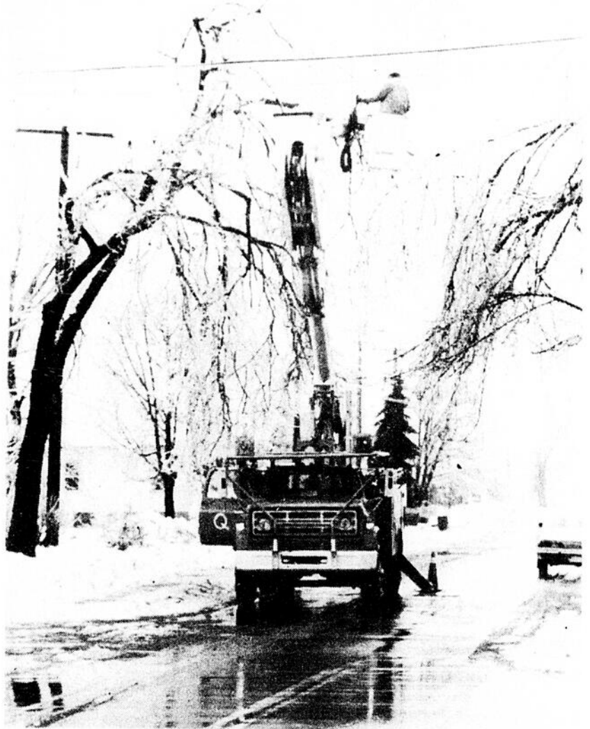
Les employés de l'Hydro-Québec du secteur ont eu fort à faire mercredi, le 14 décembre dernier, afin de rétablir le service aux milliers d'abonnés de la région privés d'électricité à cause de la plus importante tempête de glace depuis 1961. Cette scène a été remarquée à plusieurs endroits et ce à maintes reprises.
