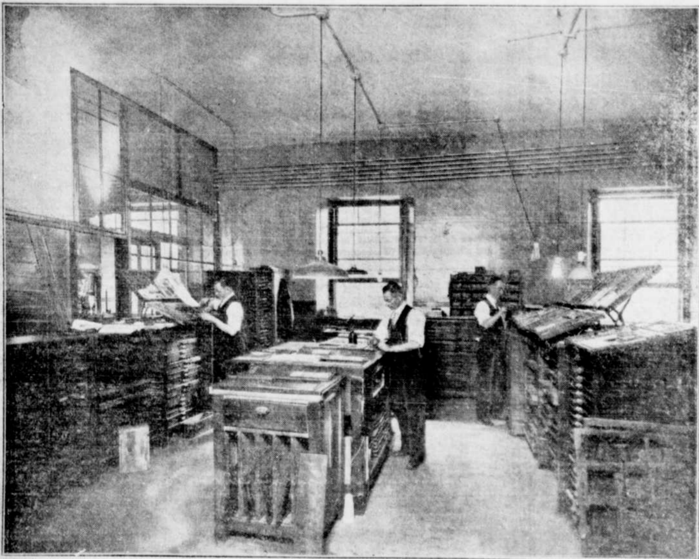
C'est ici que se composent les travaux d'impressions qui, une fois terminés, prennent la route de la presse. MM. Donat Girouard, Willie Lemelin et Georges Gingues sont ici au travail.
