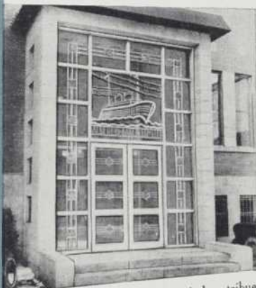
Le lustre riche et discret du métal contribue à la beauté de l'ensemble architectural, comme en témoigne l'édifice de la Cie Albert G. Baker Limited à Québec.
