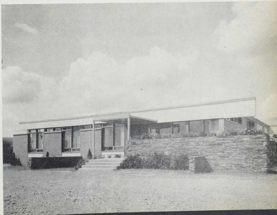
Vue de face qui souligne bien la disposition asymétrique des jardinières qui se lient à la construction et deviennent indispensables à l'ensemble.
