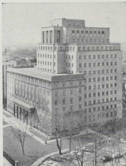
Edifice Manufacturers Life Insurance Company, Toronto, Ontario. Architectes : Marani and Morris; Ingénieurs conseils en structures : Wallace and Carruthers; Entrepreneurs généraux : Anglin-Norcross Ontario Limited; Ingénieurs conseils en mécanique et électricité : Wiggs, Walford, Frost and Lindsay; Ingénieur conseil associé pour la climatisation d'air : Charles S. Léopold.
