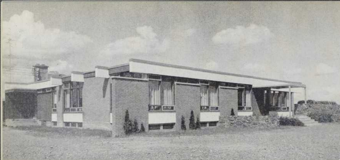
Ci-contre, vue de trois-quarts accentuant le jeu des solives projetées en saillies latérales. La photo de la page précédente détaille davantage le raffinement de l'accès avec sa marquise ténue qui s'entoure de charmantes jardinières.
