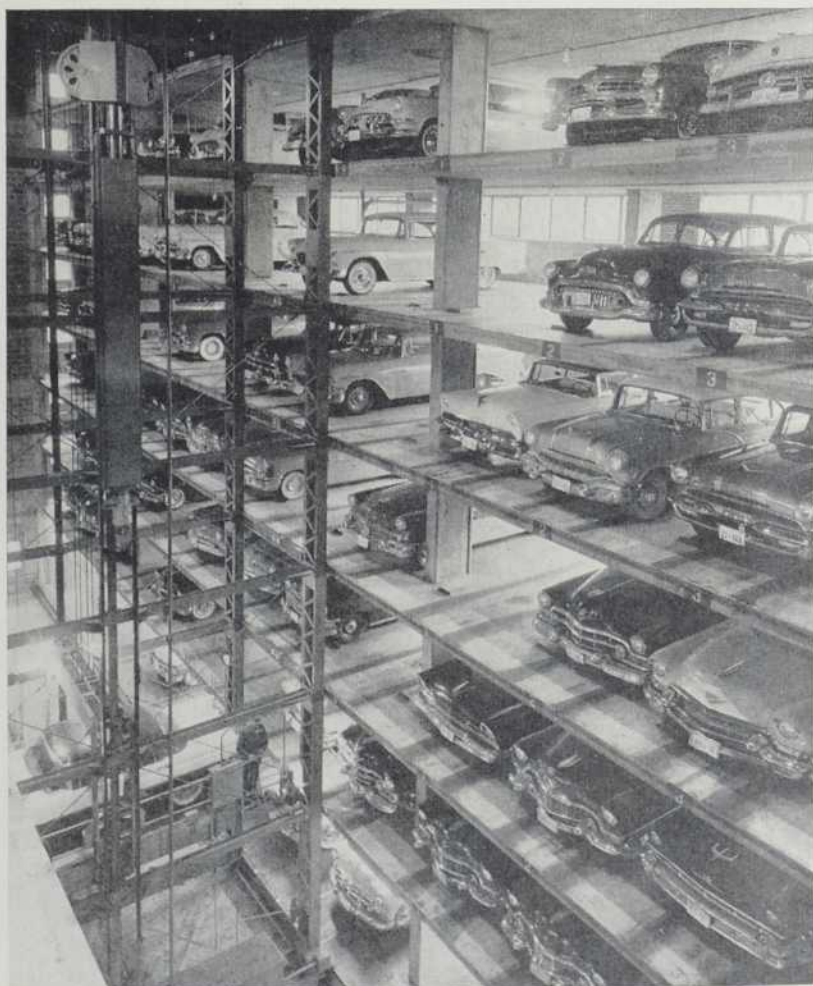
Vue en plongée des stalles de stationnement. Calculées dans le but d'économiser l'espace elles laissent si peu de place entre les autos qu'il est impossible d'en ouvrir les portières. Il n'en est nullement besoin d'ailleurs puisque la manipulation se fait de l'extérieur. On aperçoit, ancrés dans le béton, les crans d'arrêt pour prévenir tout mouvement des voitures vers le vide. Le garage peut loger à la fois quelque 255 voitures sans compter l'espace extérieur qui peut accommoder une quarantaine d'autres voitures.
