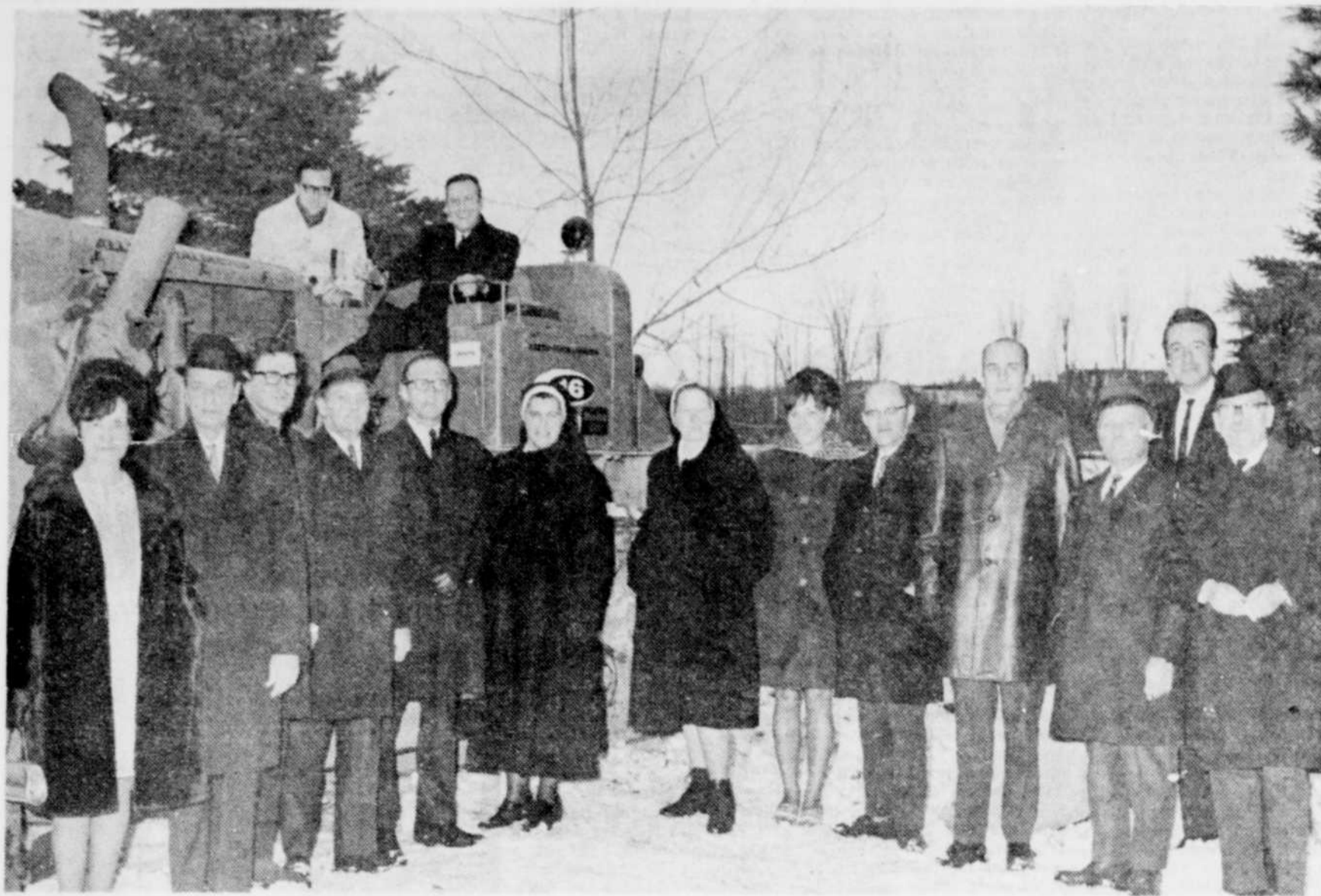
LE DÉPUTÉ PROVINCIAL DE RICHELIEU, M. Maurice Martel en compagnie du président du conseil d'administration de l'Hôtel-Dieu de Sorel, M. Robert Bourassa, conduisant pour la circonstance un bélier mécanique, lors de l'inauguration des travaux d'agrandissement de l'hôpital, samedi. De gauche à droite: M. et Mme Georges Martel, père et mère du député, M. Raymond Proulx, membre du conseil d'administration, Dr Robert Lamonde, représentant du conseil des médecins au conseil d'administration, M. Laurent Marchand, vice-président du
