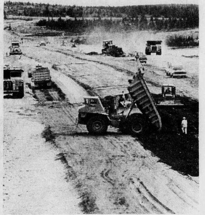
ENTREPRISE PUBLIQUE — Des camions hauts comme des maisons de deux étages transportent de la terre pour endiguer la rivière Caniapiscau, à l'installation hydro-électrique de la Baie James. (Photo PC)
