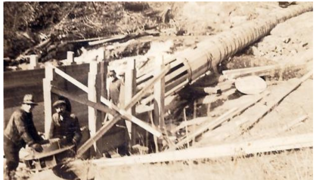
Construction du flume en bois – octobre 1935. Crédit photo : Pierre Meilleur.
