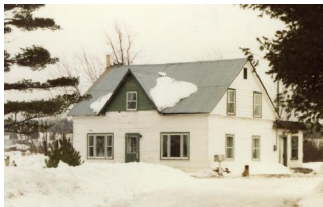
La « Concerne », première maison de Ferme-Neuve, en 1982. Source : Collection de la SHGHL.
