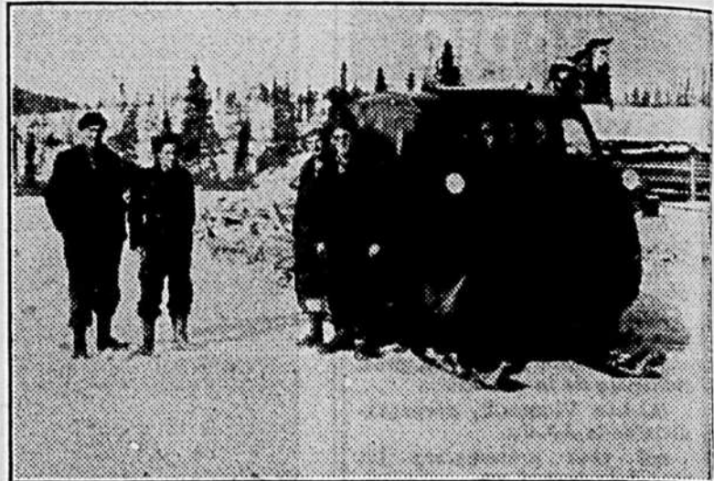
La vie de chantier a fort évolué depuis une quinzaine d'années. Il n'est plus question aujourd'hui pour les bûcherons de faire à pied ou en "sleigh" un trajet de 20 ou 25 milles. L'auto-neige moderne "bombardier" comme celle photographiée ici est le cheval moderne du chantier. Montée sur deux patins avec chenilles à l'arrière, cette auto fait facilement du vingt à l'heure avec une charge de "pitoune". Elle est en opération à Sanmaur, Abitibi.
