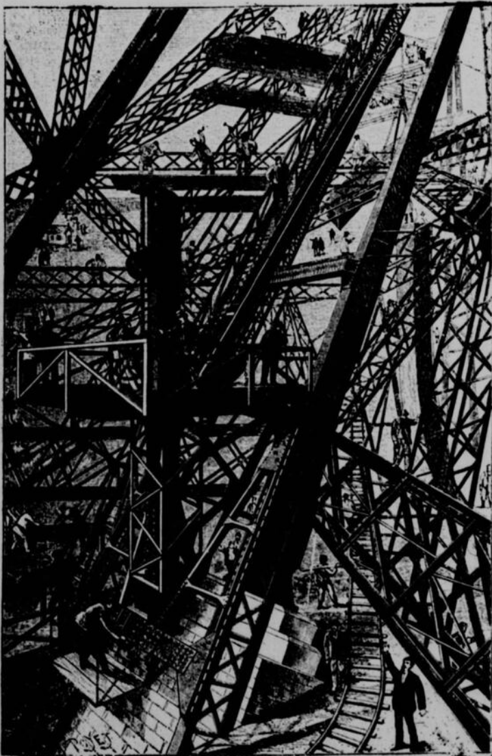
Fig. 4. — Vue d'un des 4 piliers de la Tour pendant sa construction. La grande grue enlève une énorme pièce de fer, qu'on voit à droite, en haut de la gravure
