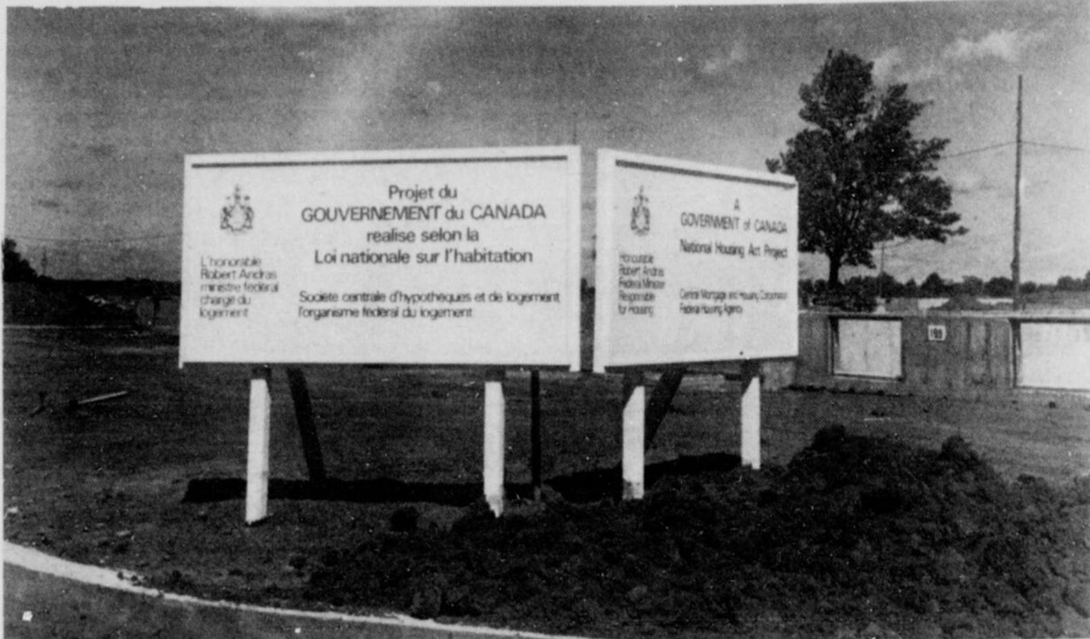
Sur l'emplacement d'un immense chantier de maisons destinées aux gens qui ne sont pas riches, à Fabreville.
