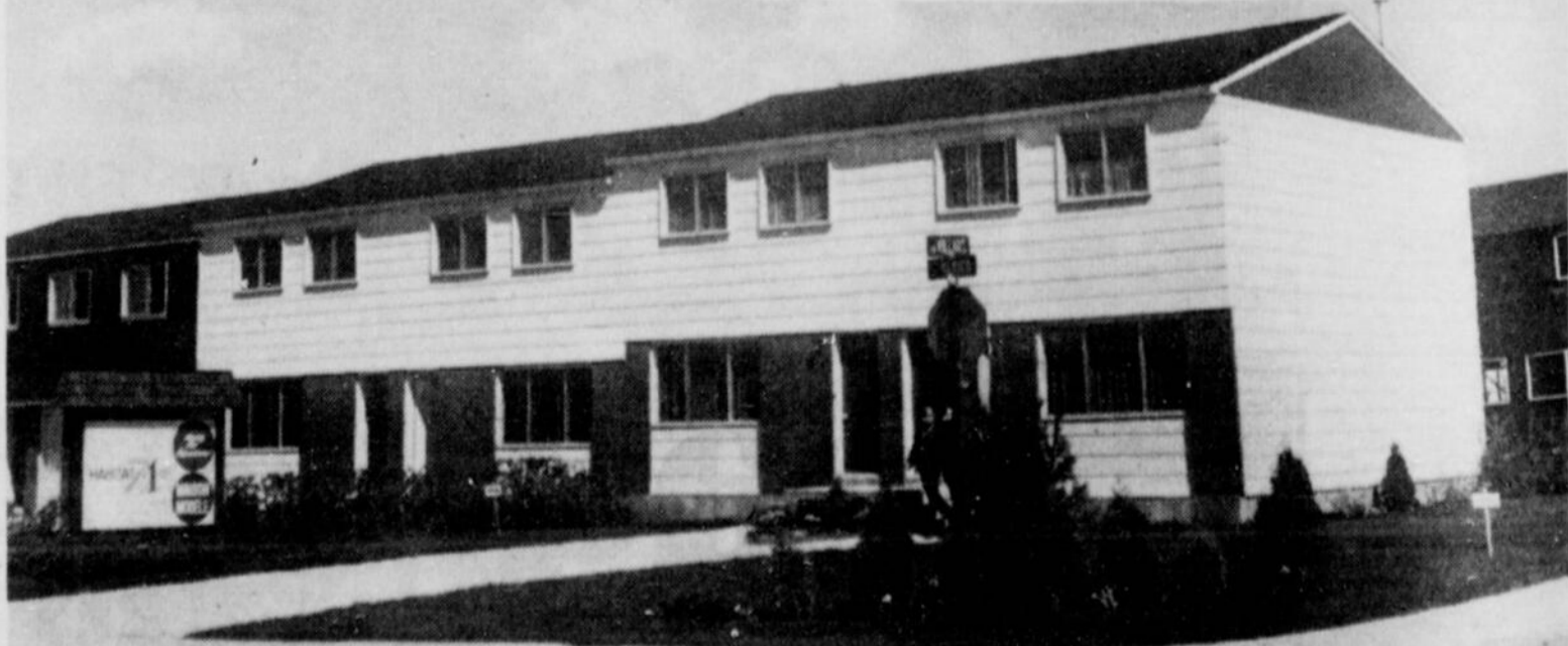
Cottages en rangée. L'habitation se vend $11,850 et on nous assure qu'on peut en devenir propriétaire à raison de $99.50 par mois. Chaque habitation a deux étages.
