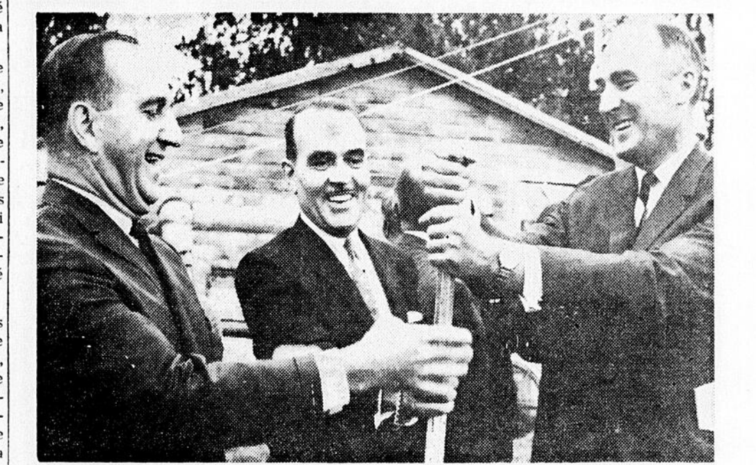
Le gouvernement provincial a procédé, la semaine dernière, à la pose du premier piquet en vue de l'arpentage pour la construction de l'autoroute Montréal-Sherbrooke. On reconnaît ici, dans l'ordre habituel, Me Pierre Laporte, député de Chamby, M. Guy Poliquin, président de l'Office des autoroutes du Québec et M. Bernard Pinard, ministre provincial de la Voirie.
