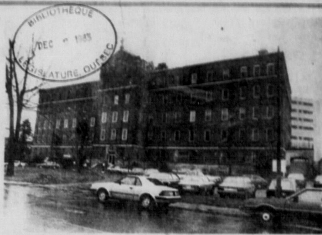
L'ancien hôpital de Valleyfield sera rénové au coût de $5.7 millions. Les travaux devraient être complétés à l'automne 1986. (Photo Le Soleil Pierre Langevin)
