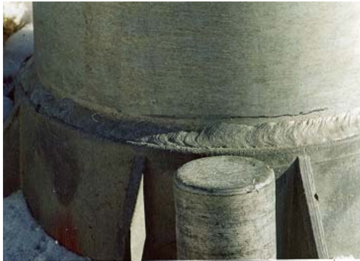
Photographie 5.5-2 Évaluation du comportement du poteau
