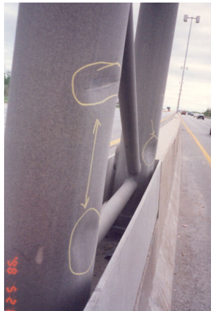
Photographie 5.5-3 Évaluation du comportement des poteaux d'un support en treillis
