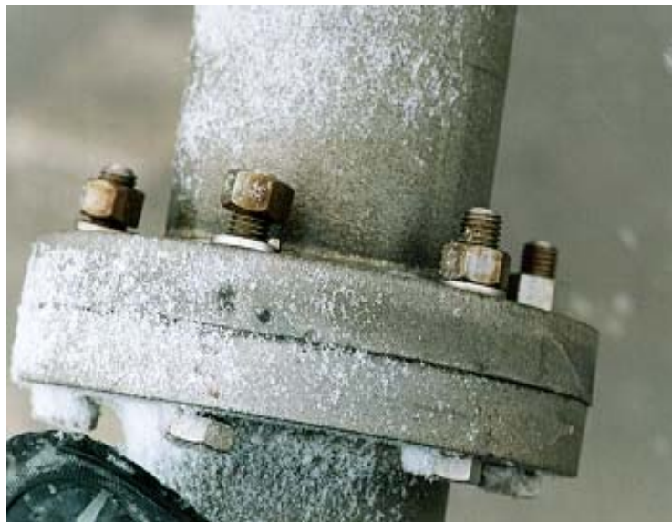
Photographie 5.8-2 Évaluation du comportement des assemblages boulonnés
