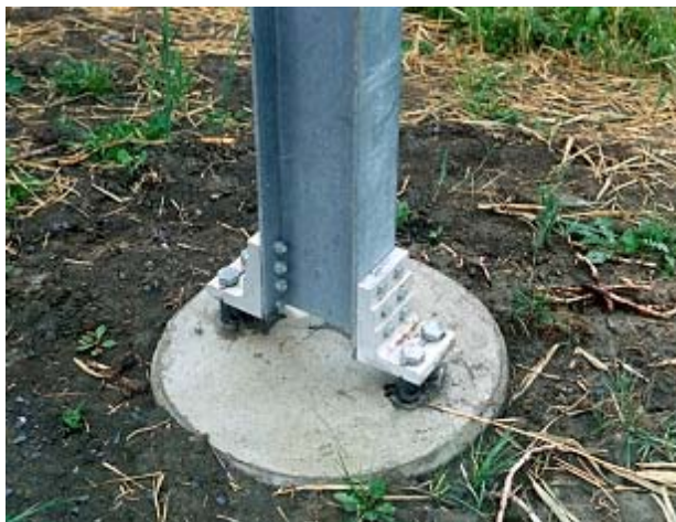
Photographie 1.4-6 – Système « Break-Safe »
