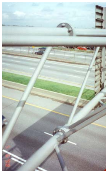
Photographie 5.6-10 Évaluation du comportement des membres secondaires d'un support en treillis
