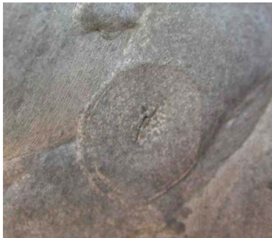
Photographie 5.7-1 Évaluation du comportement des assemblages soudés
