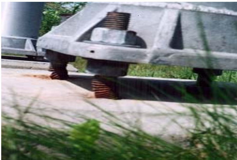
Photographie 5.4-6 Évaluation du comportement des tiges d'ancrage
