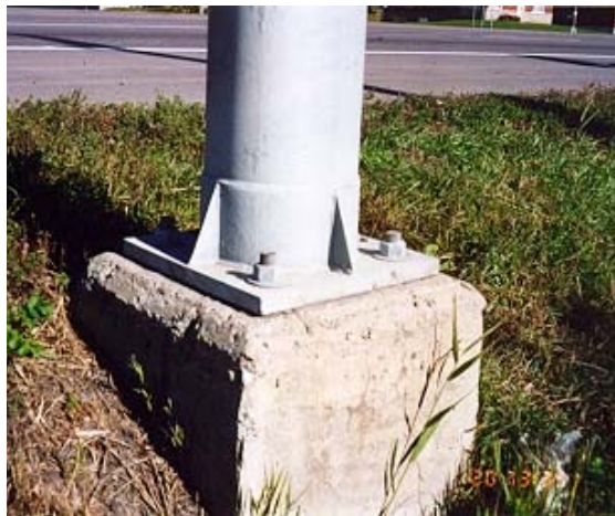
Photographie 5.3-8 Évaluation du comportement du remblai
