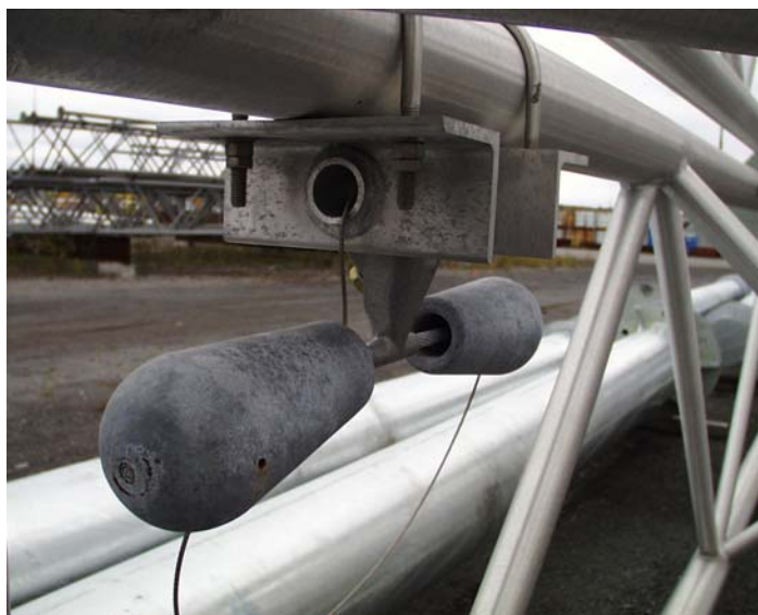
Photographie 1.5-10 – Amortisseur de vibrations
