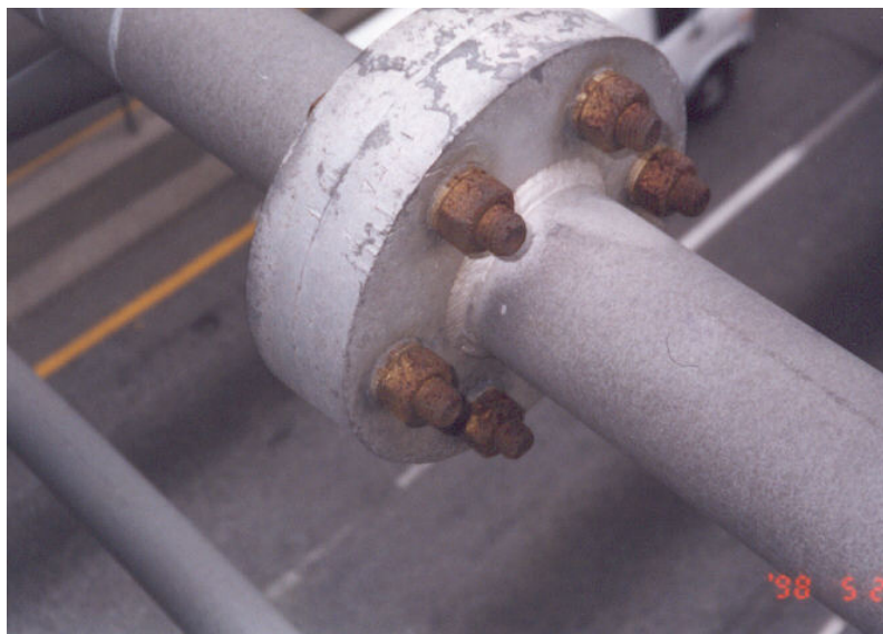
Photographie 5.8-4 Évaluation du comportement des assemblages boulonnés
