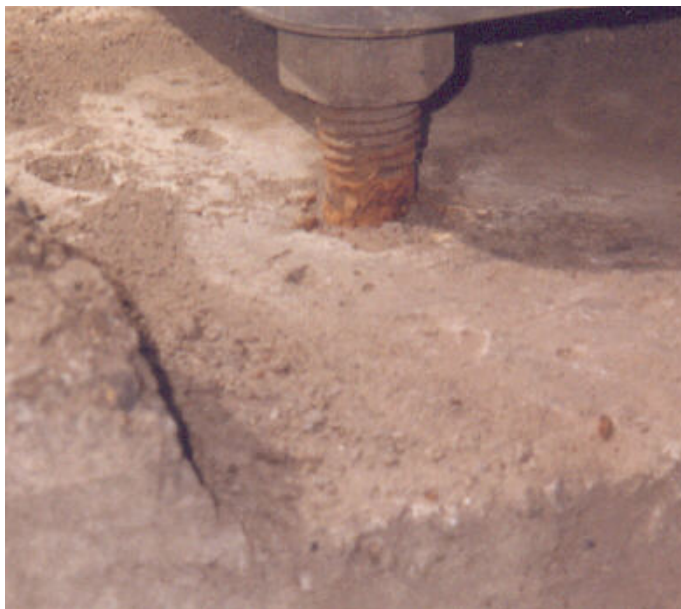
Photographie 5.4-1 Évaluation du comportement des tiges d'ancrage
