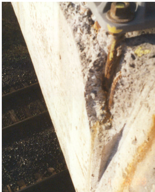
Photographie 5.4-4 Évaluation du comportement des tiges d'ancrage
