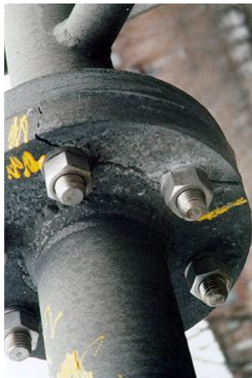
Photographie 5.8-1 Évaluation du comportement des assemblages boulonnés
