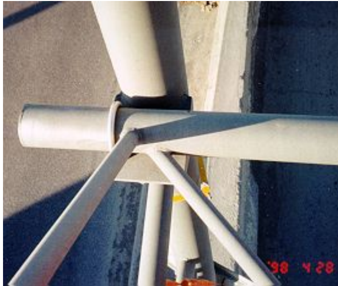
Photographie 5.9-6 Évaluation du comportement des éléments d'appui et d'assemblage du support horizontal
