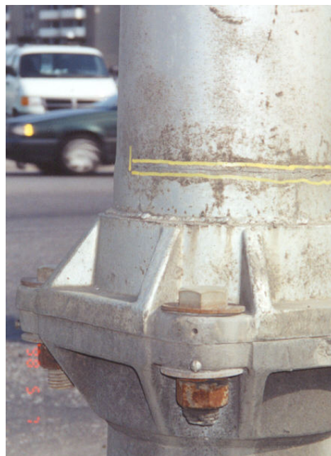
Photographie 5.5-5 Évaluation du comportement du poteau
