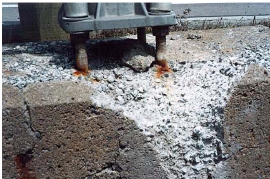
Photographie 5.4-2 Évaluation du comportement des tiges d'ancrage
