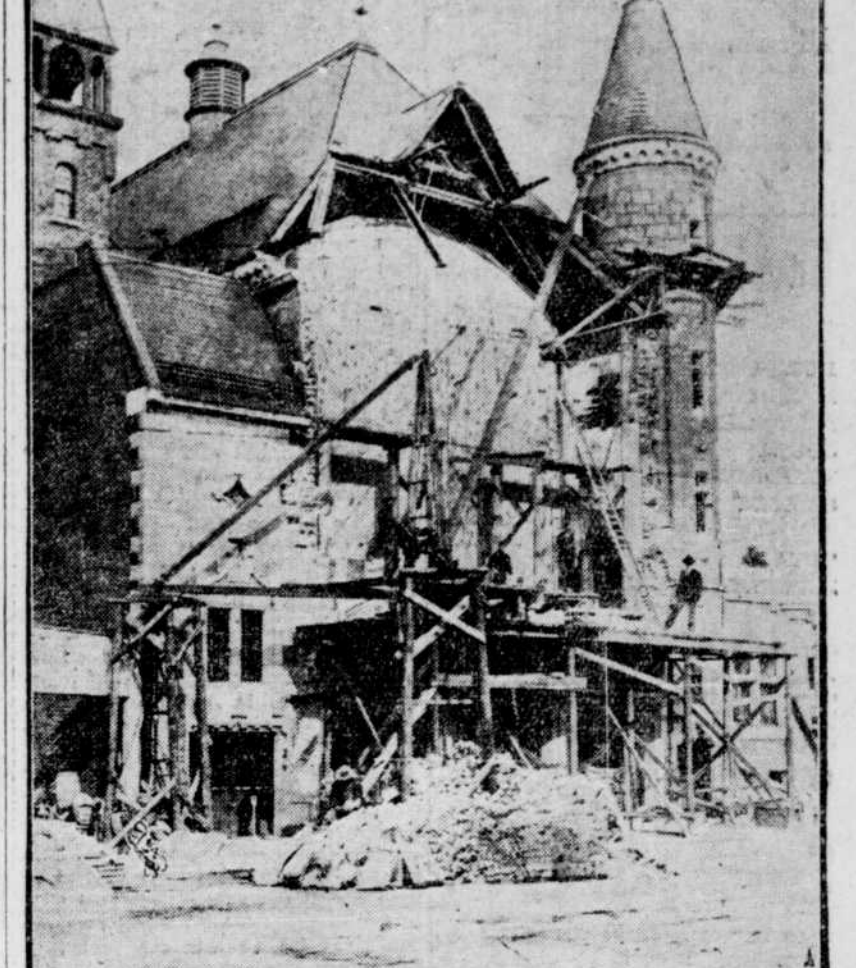
L'hôtel de ville de Saint-Louis, dont on vient de démolir la façade, pour cause d'un défaut de construction.
