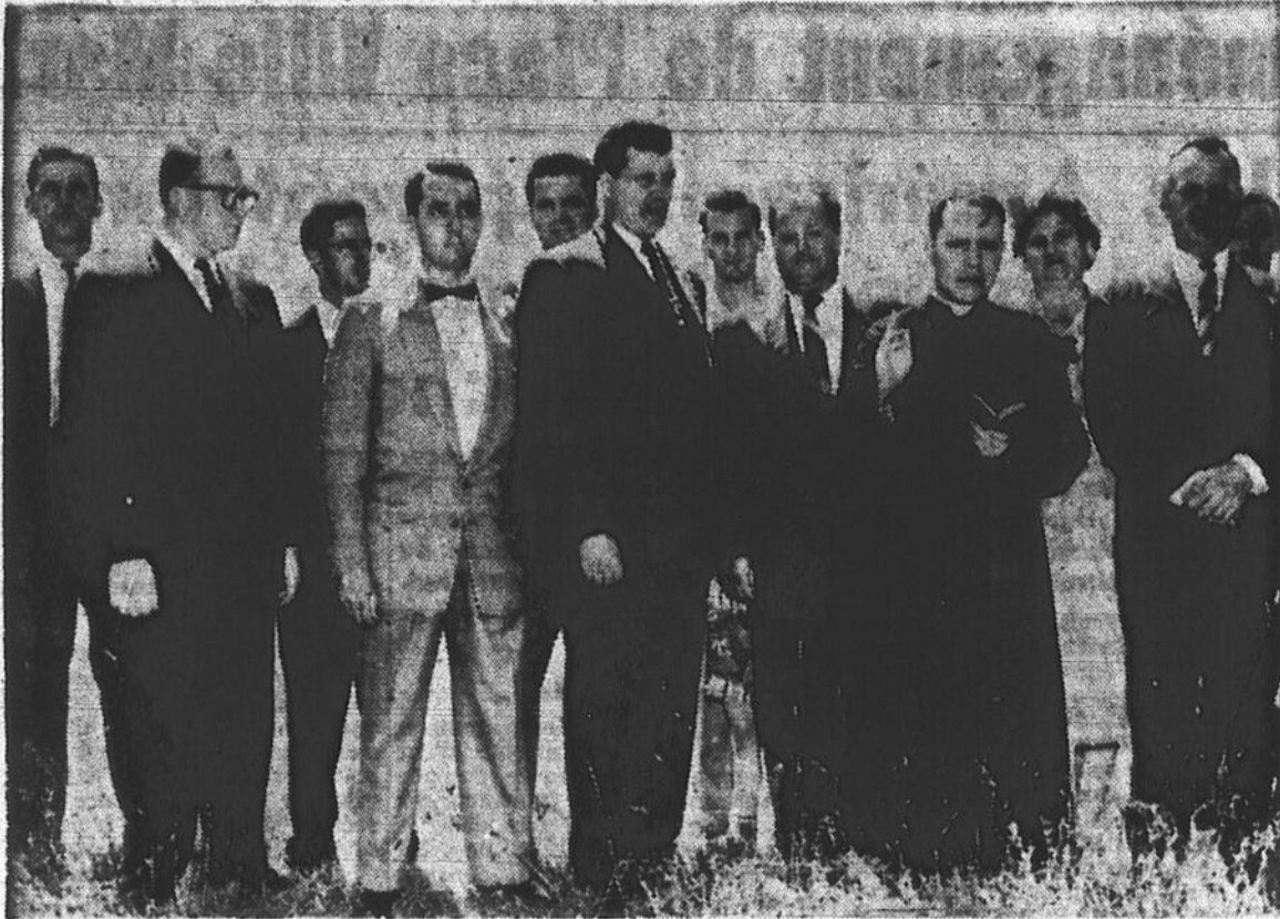
UNE QUATRIEME ECOLE A ST-VINCENT-DE-PAUL — Une quatrième école sera construite à St-Vincent-de-Paul cette année et sera prête à recevoir les filles et garçons dans quatorze classes dès le mois de septembre 1959. M. le curé Bergevin a béni l'emplacement de cette école située à la sortie du pont Pie-IX, hier, en présence de M. Roger Lortie, président de la Commission scolaire de cette municipalité, et des commissaires G. Pilon, M. Jobin, H. Chartrand, A. Audet, ainsi que du secrétaire-trésorier, M. Rolland Bernard. La Commission a obtenu un octroi de $200,000 du gouvernement provincial grâce à l'intervention du député de Laval, M. Léopold Pouliot. (Photo "Montréal-Matin")
