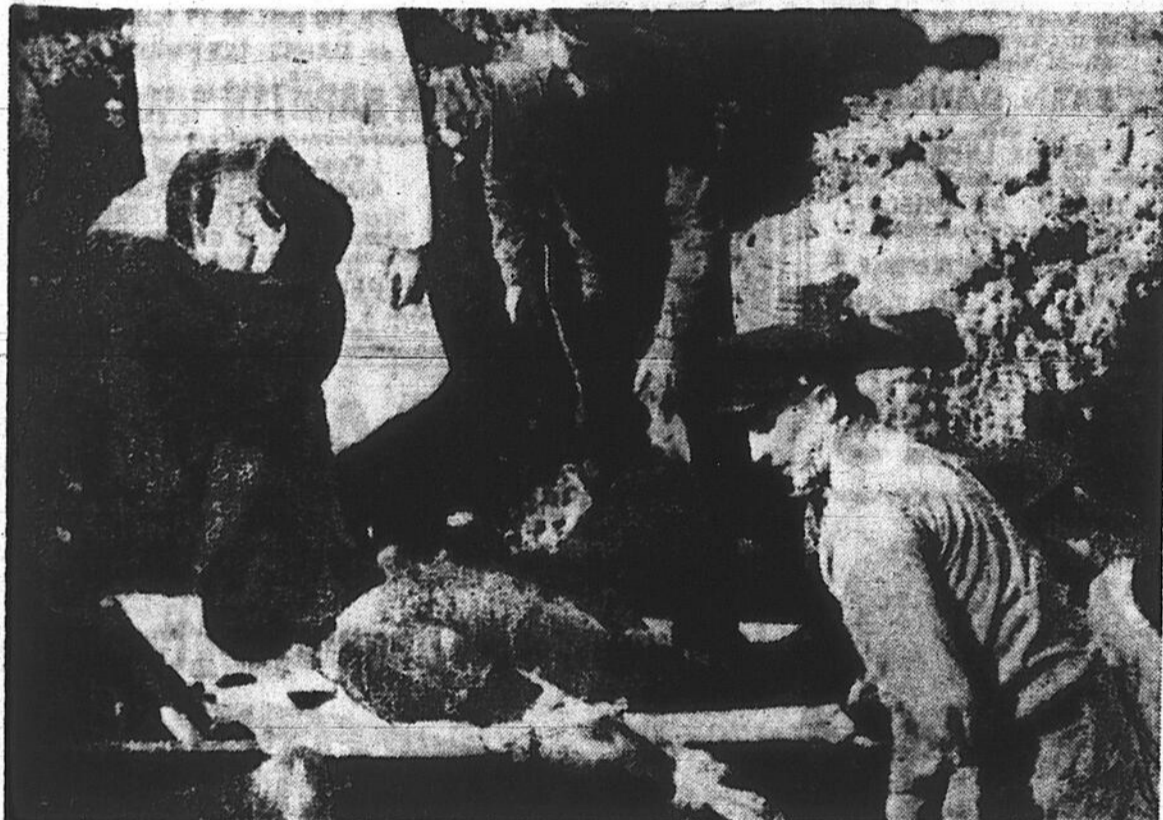
IL A SURVECU MIRACULEUSEMENT — Des pompiers de Détroit apportent sur une civière un ouvrier blessé qui a été enseveli vivant avec un compagnon qui a perdu la vie. Les deux hommes travaillaient dans une profonde tranchée, dont une paroi s'est écroulée sur eux. Au bout d'une heure, on a pu les en retirer. Le corps de celui qui a perdu la vie reposait sur le visage de l'autre. On attribue à ce fait qu'il ait eu la vie sauve. (Fac-similé UPI — "Montréal-Matin")
