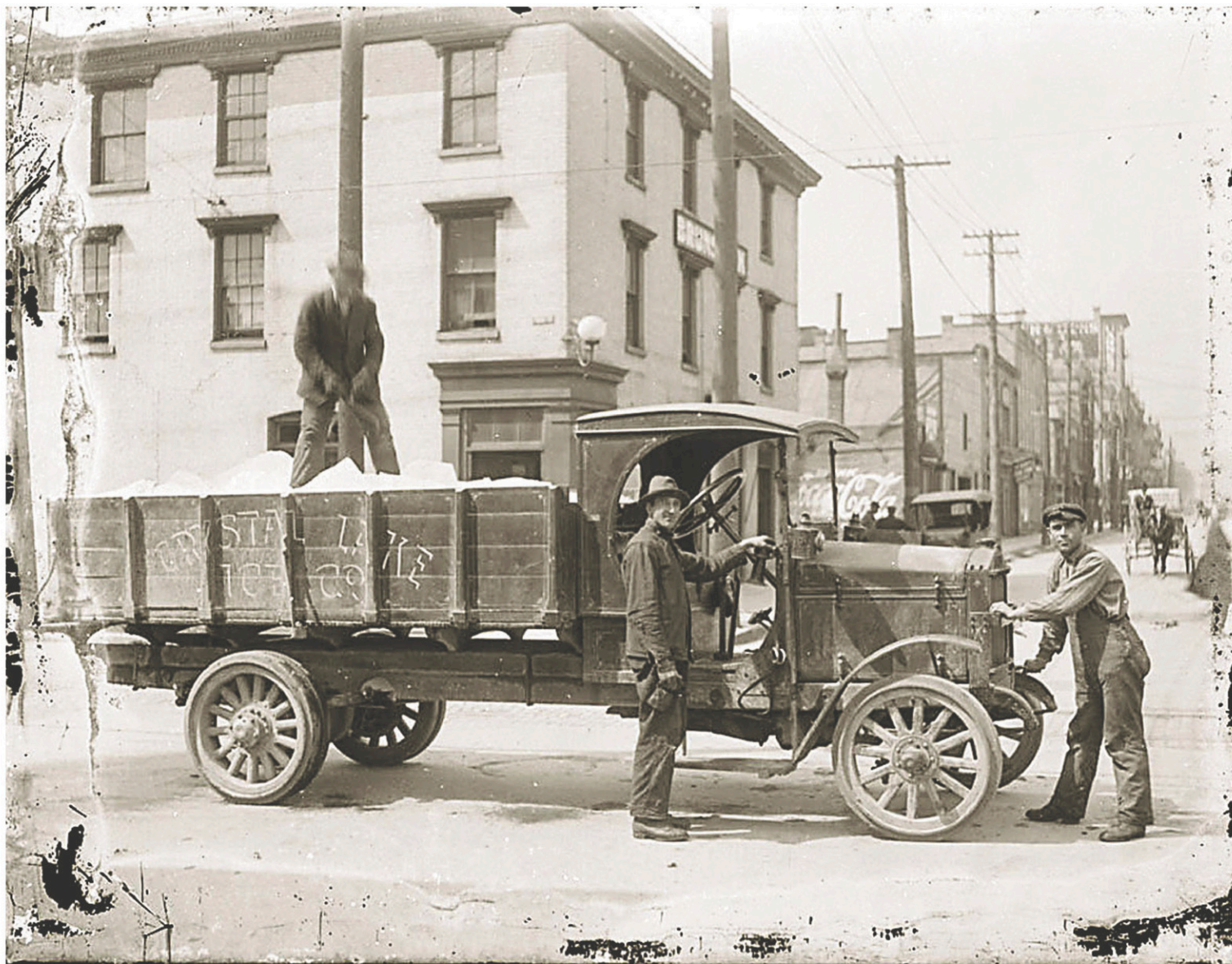
Les marchands de glace sillonnaient les rues des villes en été pour la distribuer. Récoltées dans les cours d'eau pendant l'hiver, les montagnes de glace étaient recouvertes de sciures de bois, parfois de paille aussi, pour les isoler autant que possible en été.
