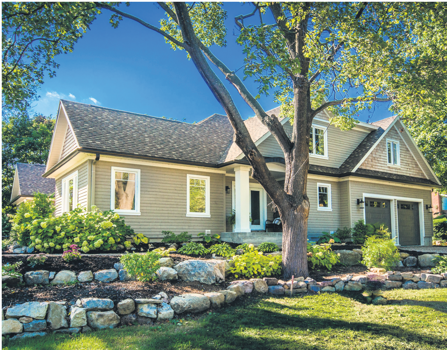
PHOTOS FOURNIES PAR SOTHEBY'S INTERNATIONAL REALTY CANADA Après rénovation, le plain-pied a gagné un étage au-dessus du garage. Même si l'entrée principale est située sur le côté gauche donnant sur un boulevard, le va-et-vient se fait surtout par l'accès à une rue secondaire. L'allée est en pierre de rivière et les roches proviennent de l'excavation du terrain.
