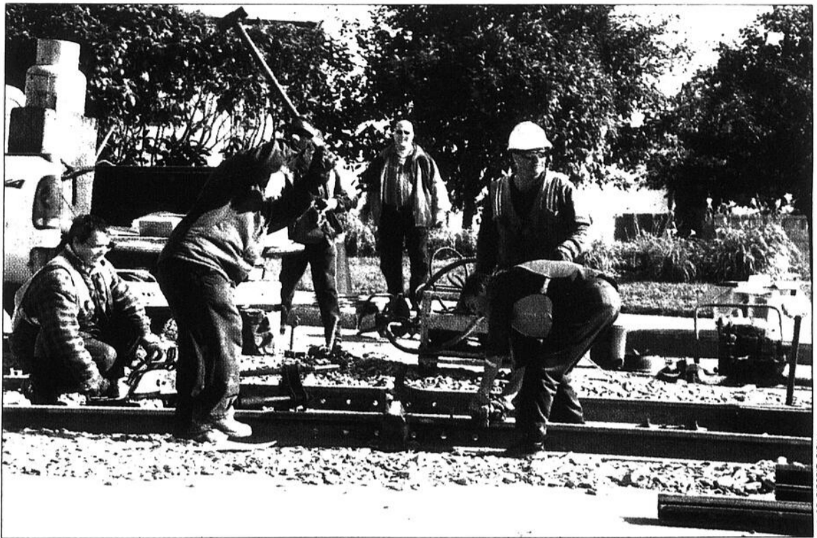
La pose de nouveaux rails et d'ornières de caoutchouc au passage à niveau de la rue Frontenac a nécessité deux jours de travaux pour les équipes d'entretien. Seuls les véhicules d'urgence pouvaient franchir le site, le trafic régulier étant détourné par le prolongement du boulevard des Vétérans et la rue Victoria.
