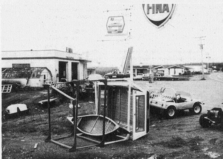
Cette fois c'est la cabine d'un camion qui s'est complètement détachée de la boîte. Cette scène s'est passée au Lac Etchemin.
