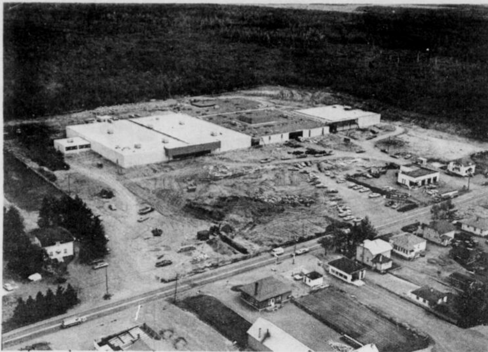
VUE AÉRIENNE du nouveau Centre d'Achats "Les Galeries du Lac St-Jean", d'Alma dont l'ouverture officielle aura lieu le 12 du mois d'août prochain.
