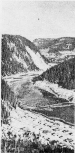
Emplacement du futur barrage de Manic III, sur la Manicouagan. — (Photo Hydro-Québec.)
