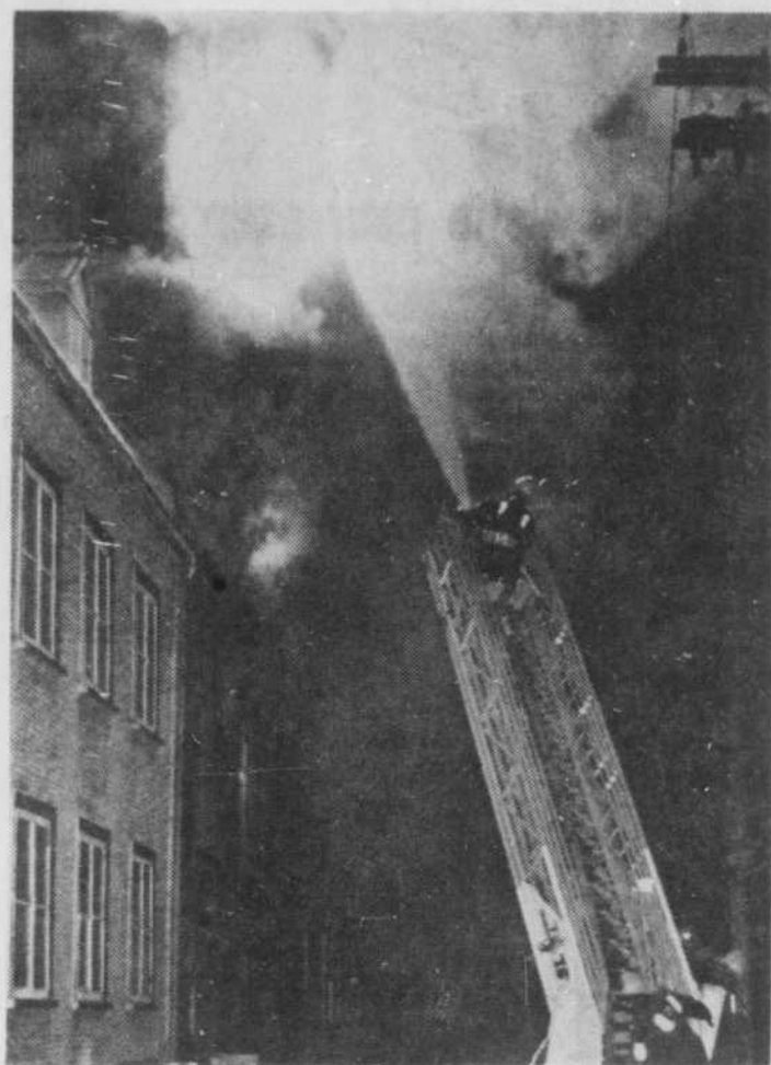
La photo témoigne de la violence de l'incendie qui a détruit une maison de rapport de quatre étages dans la rue Sainte-Famille, hier soir.
