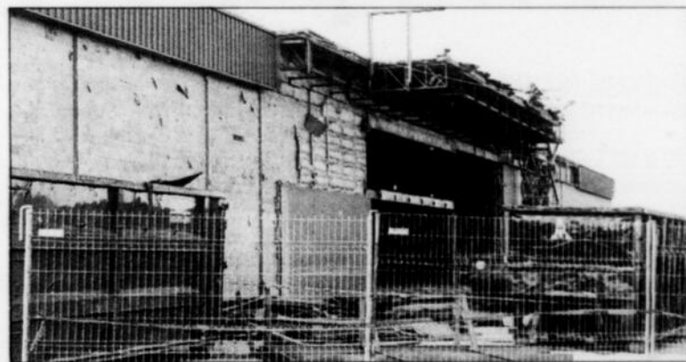
Au cours des dernières semaines, des travaux majeurs ont été entrepris dans le local de l'ancien Zellers ainsi que sur la façade. Le propriétaire du IGA de la rue des Champs-Élysées confirme que le local laissé vacant est en préparation pour le futur supermarché.
