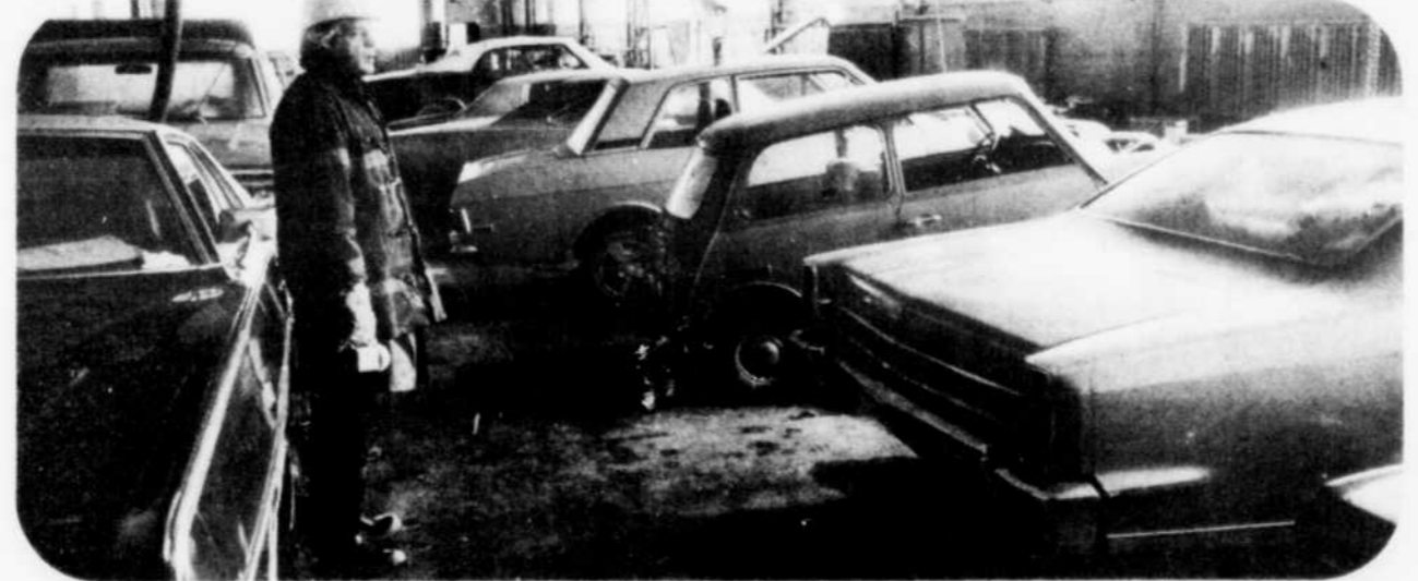
La seule partie intacte de l'édifice, le sous-sol abritant l'atelier de mécanique.
