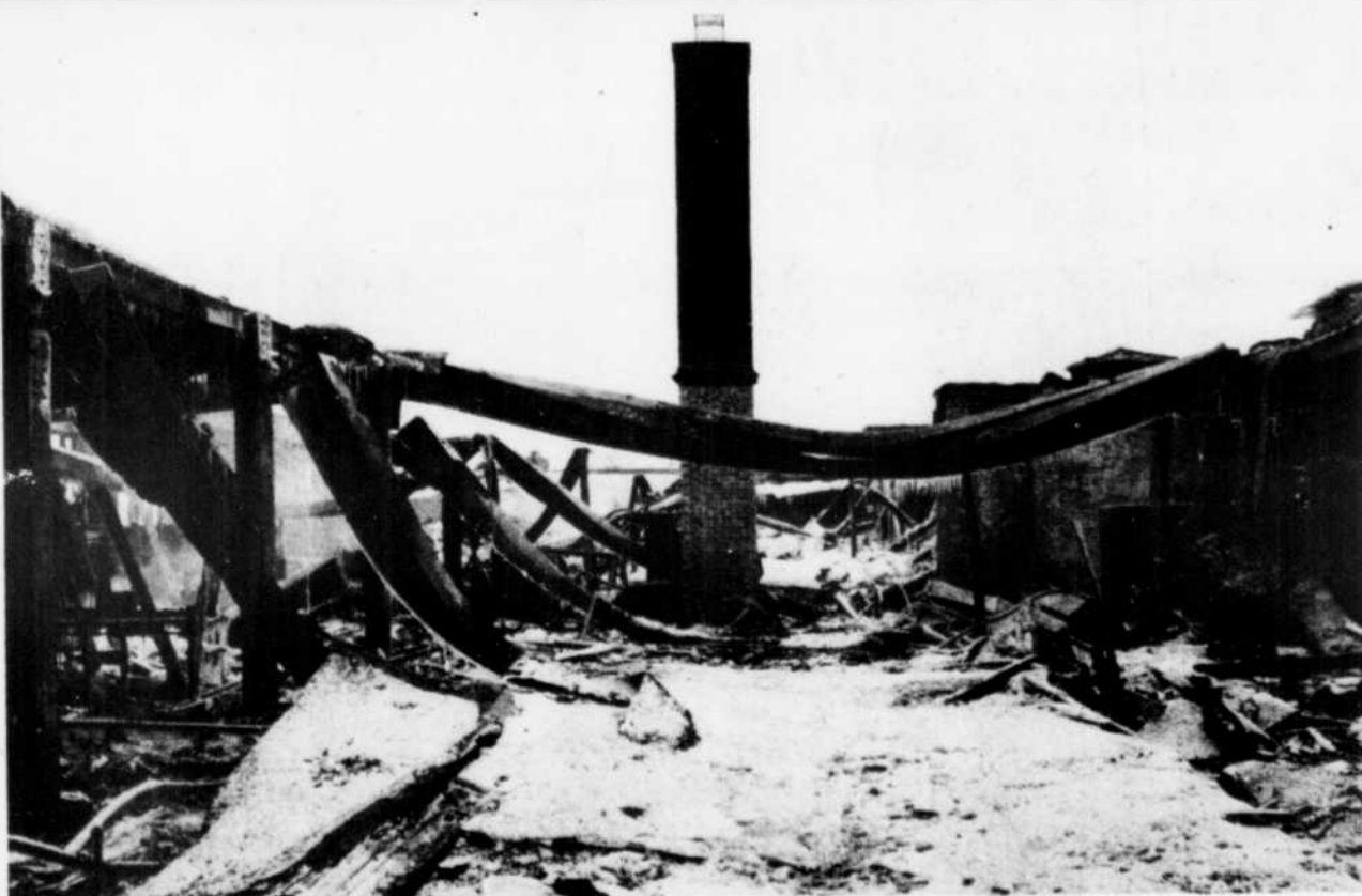
Les poutres d'acier du vieil édifice ont tordu comme du carton-pâte...
