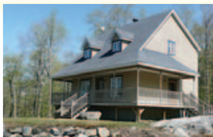
DOMAINE AU LAC EN COEUR - Plus de 21 acres avec maison à étages 2005 et dépendances. Poss. d'usage ferme. Vue panor. Accès au lac. Chevreuils et orignaux inclus. (MLS 9986364) 389 000 $
