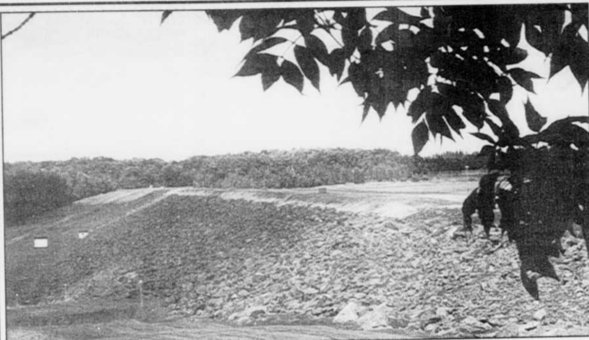
Le barrage Choinière ne risque pas de se fissurer. Mais après les événements du Saguenay à l'été 96, les images de désolation transmises à la télé auront finalement convaincu tout le monde, le gouvernement en premier lieu, de l'importance d'un tel plan d'évacuation.
