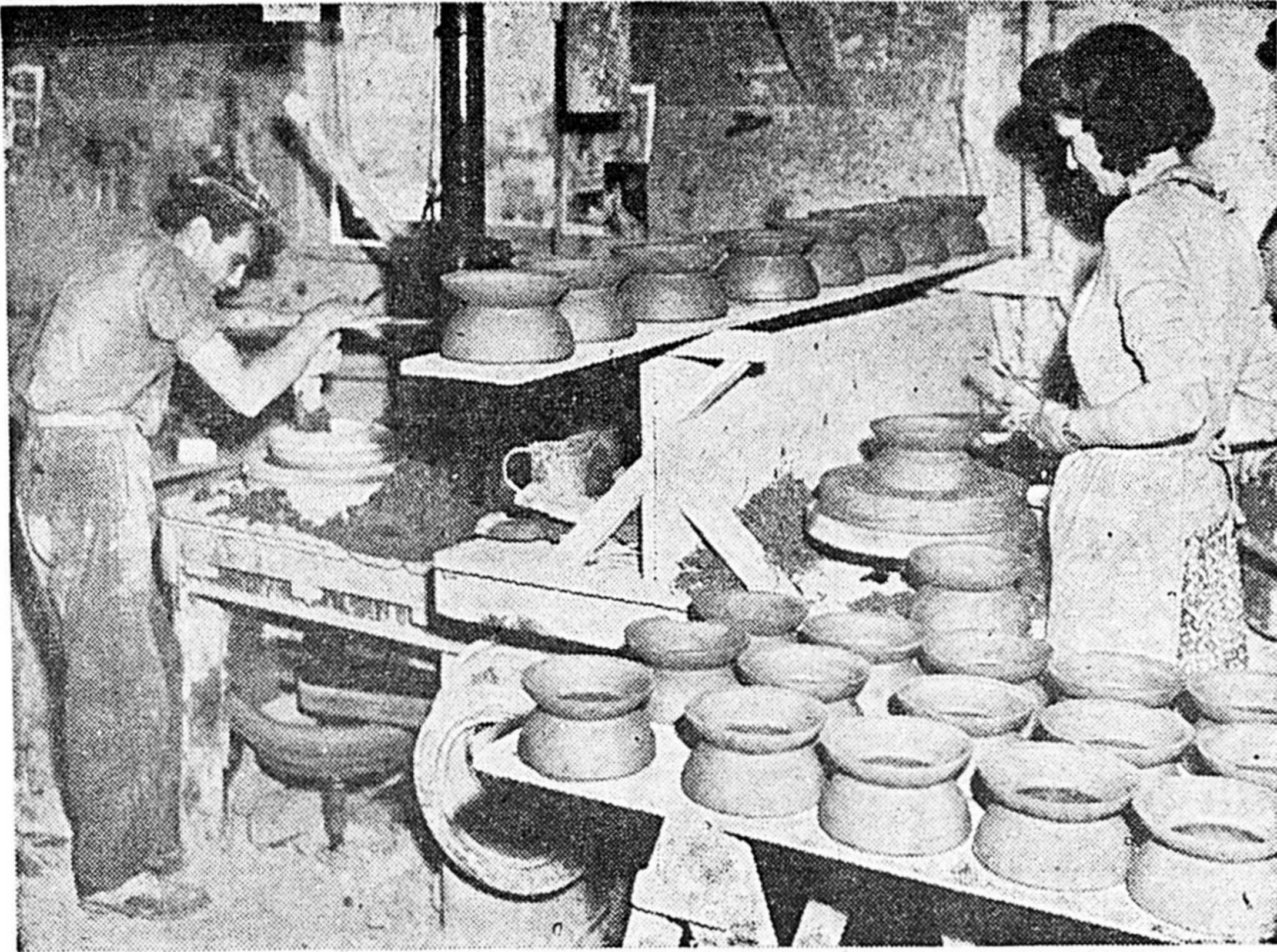
Après que la pièce a été calibrée, on ne manque pas de la retoucher soigneusement. On voit ici M. Raymond Tremblay et Mlle Madeleine Gagnon qui s'occupent de ces deux opérations. Il s'agit de la fabrication d'un crachoir.
