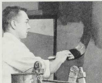
...en travaux de peinture
