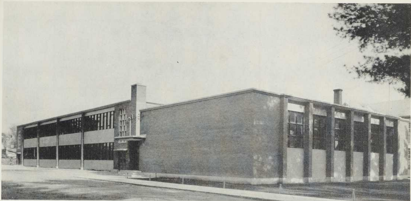
Autre vue latérale donnant sur la cour de récréation. Le gymnase, identifié par sa haute fenestration et son mur aveugle, donne sur la rue.
