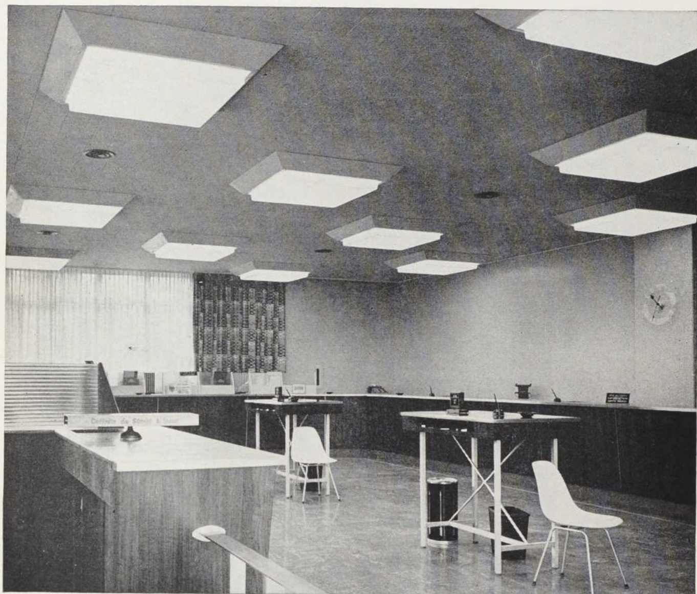
Des plafonniers en "Perspex" dispensent des flots de lumière dans cette succursale de banque
