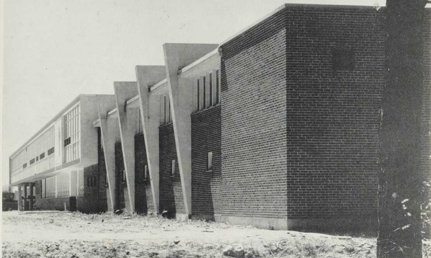
Page précédente et ci-contre, deux vues opposées de la façade principale, la première soulignant le prolongement du bloc scolaire sur piliers, la seconde le gymnase avec sa structure catégoriquement extériorisée.
