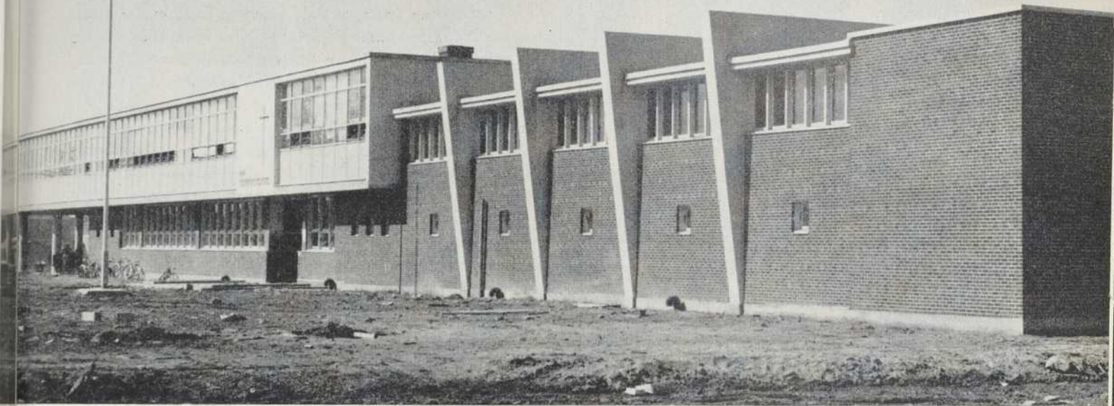
ECOLE STE-CATHERINE-DE-SIENNE angle des rues Somerled & Coronation, Montréal, P.Q. Cette école fut construite par J. E. Vincent Ltée, Entrepreneurs; Deslauriers & Mercier, Ingénieurs-Conseils; Duplessis, Labelle et Derome, Architectes; tous de Montréal.
