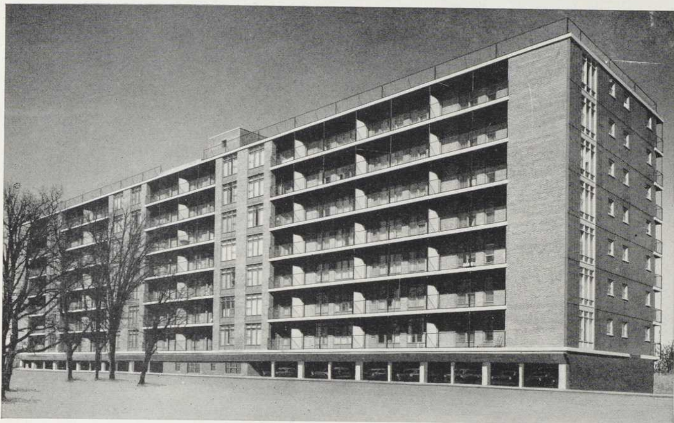
APPARTEMENTS PARK TOWERS, WINNIPEG (Entrepreneur: Frank R. Lount & Son Ltd.)
