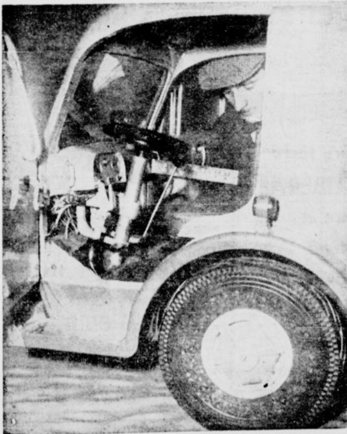
LA CABINE DU CONDUCTEUR du camion de bois fabriqué par M. Charles Roy est en bois dans la porte. Toutes les pièces à l'intérieur sont en bois de même que les roues sauf les pneus qui sont de caoutchouc.
