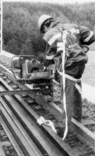
Bruno Lévesque, superviseur d'entretien de la voie au Roberval-Saguenay, et Léo Tremblay, représentant en prévention, ont expliqué leur préoccupation pour la sécurité lors des travaux sur le pont menant à l'usine Grande-Baie. On aperçoit ci-contre, les harnais spéciaux et les points d'ancrage fournis aux employés d'entretien de la voie ferrée.
