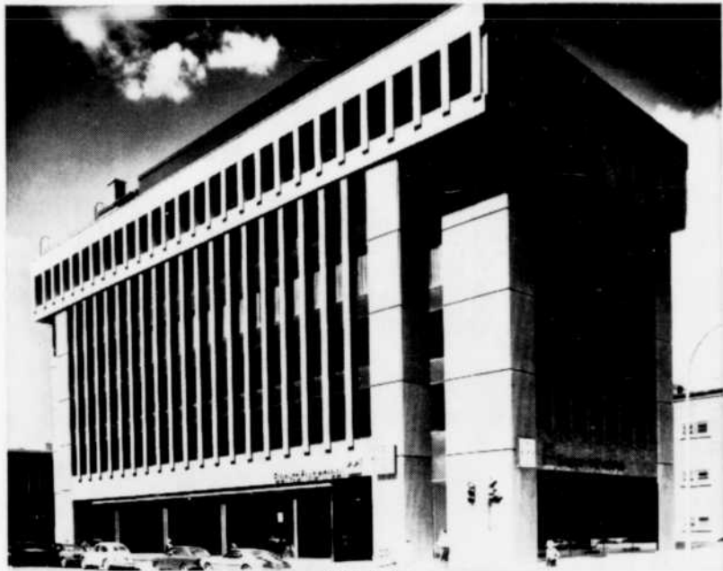
Immeuble de bureaux à Westmount (Qué.)
