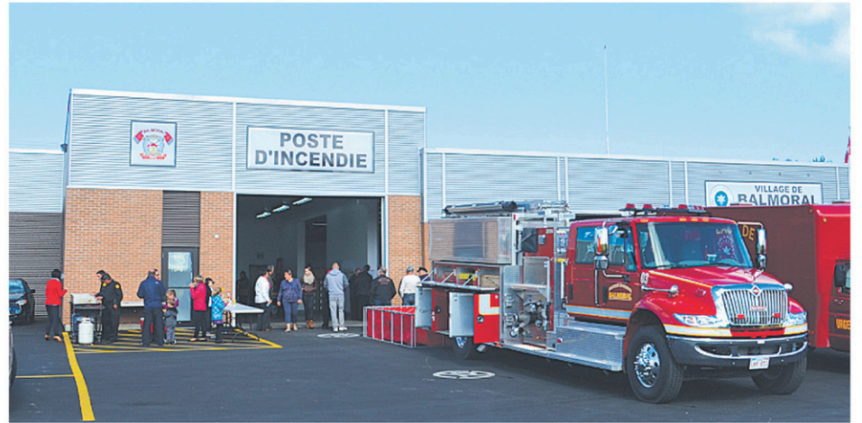
Les travaux à la caserne de Balmoral arrivent à point, pour le 40e anniversaire de la brigade incendie. (Photo Gracieuseté)
