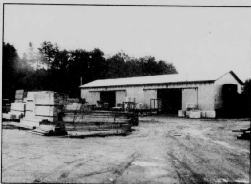
La cour à bois et les entrepôts regorgent de matériaux de construction de tous les types.
