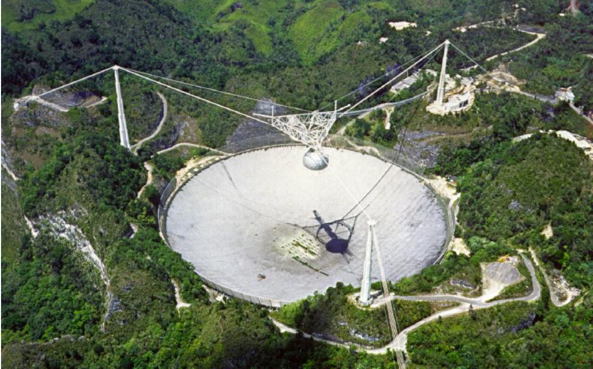
L'un des plus impressionnants radiotélescopes au monde est celui d'Arecibo, à Porto Rico. Il s'agit d'une coupole de 305 mètres de diamètre construite à même une vallée.
