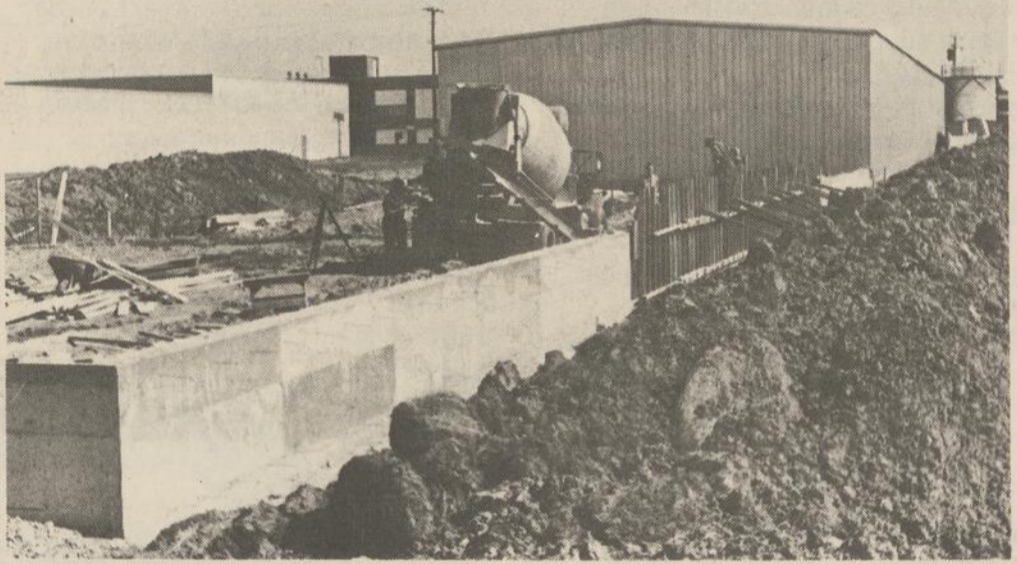
AGRANDISSEMENT --- La compagnie Regent Chocolat procède à l'agrandissement de ses locaux, à Saint-Hyacinthe, au 2950, rue Nelson. La nouvelle annexe en construction nécessite des travaux au coût de $70,000.
