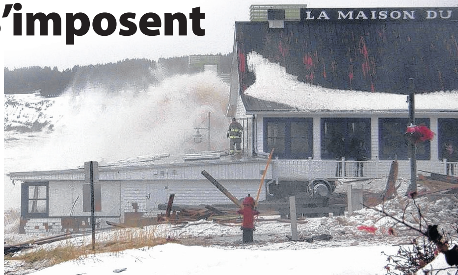
Le Café de l'Atlantique situé dans le bâtiment de la Maison du Pêcheur a été littéralement envahi de débris lors de la tempête du 30 décembre. (Photo Gracuseté - Ariane Aubert-Bonn)
