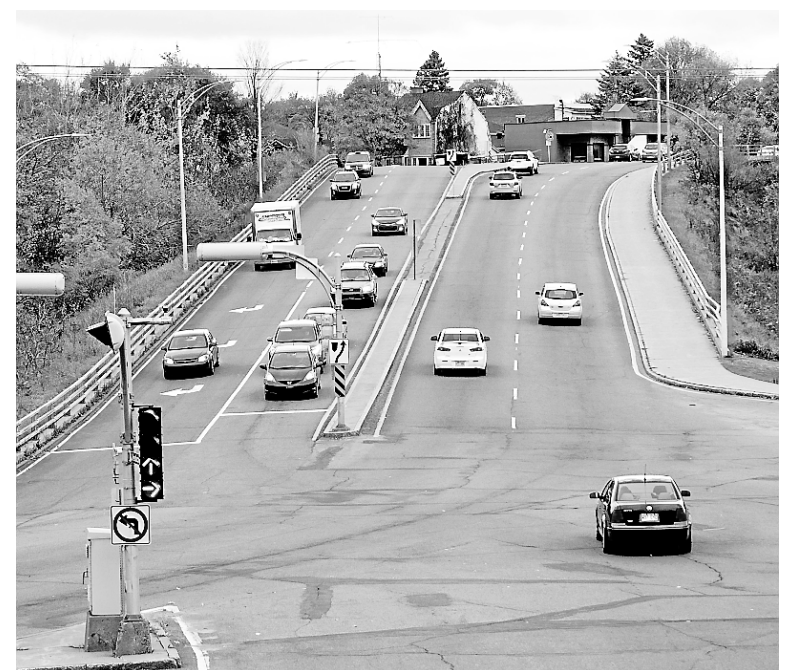
Le viaduc Saint-Marc accuse le poids des années, de sorte que la Ville de Shawinigan doit condamner la voie de droite pour une période indéterminée. Des travaux de réfection sont prévus au printemps. — PHOTO: SYLVAIN MAYER
