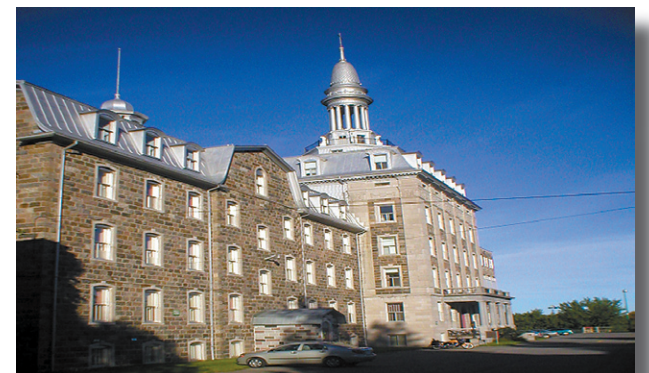
Le Centre d'intégration communautaire de Victoriaville
