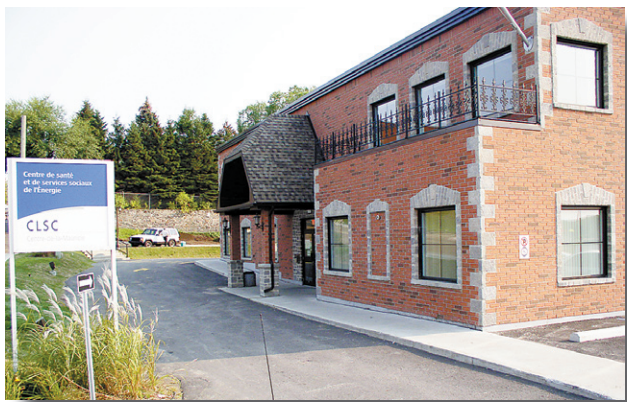
Le CLSC du Centre-de-la-Mauricie
