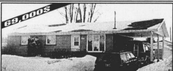
69,000$ Secteur Ste-Famille, extérieur refait à neuf. (Fenêtres, toiture, avant couverture)
