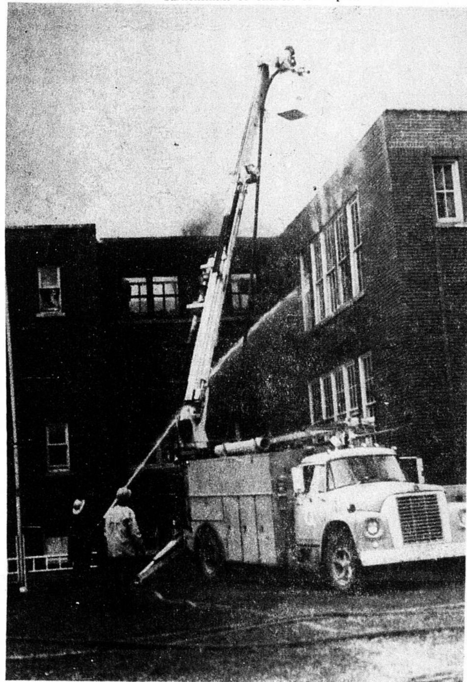
La toiture de l'école St-Joseph fut la proie facile des flammes et c'est pourquoi les sapeurs volontaires ont dû utiliser l'échelle télescopique de l'Hydro-Québec afin de mener le combat.
