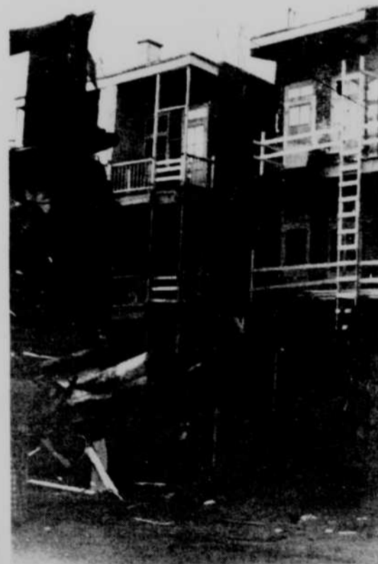
On a installé des galeries temporaires et des échelles pour garder une sortie d'urgence.
