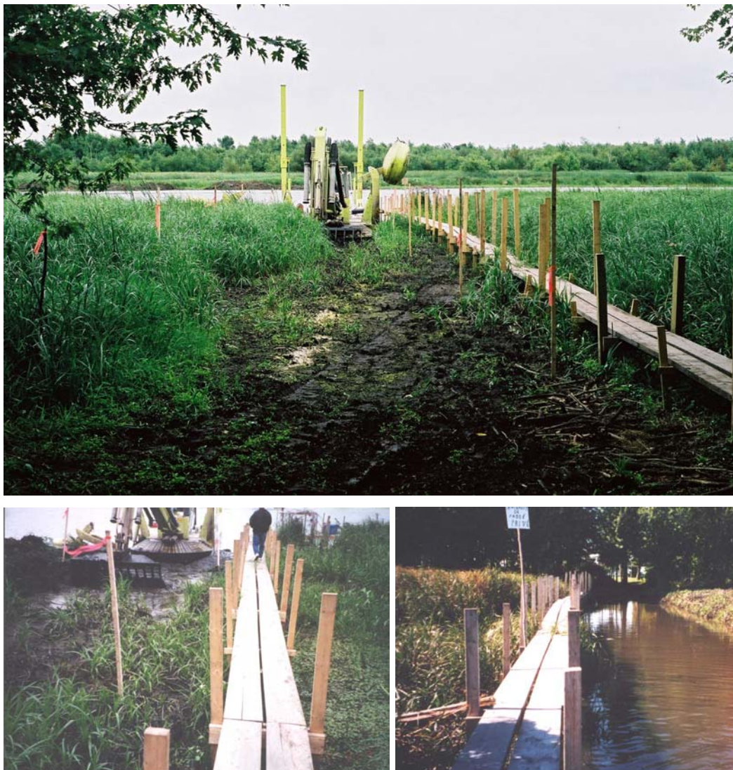
Figure 6. Vue du quai et du canal pendant et après le creusage.
