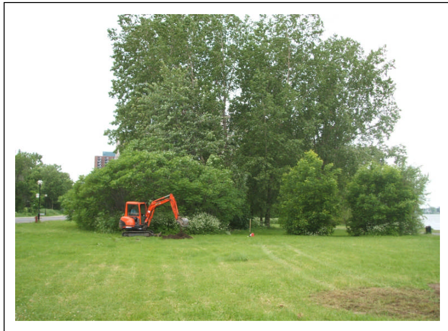
Photo 26 : (N.1-083) Projet MTQ 20-5100-8847, autoroute 25 : zone C, excavation mécanique du sondage M-4, vu vers l'ouest
