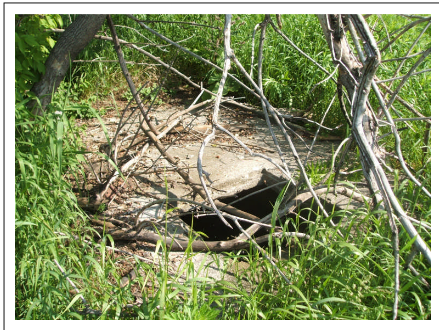
Photo 43 : (N.1-063) Projet MTQ 20-5100-8847, autoroute 25 : zone B, puits en ciment S6, vu vers le nord
