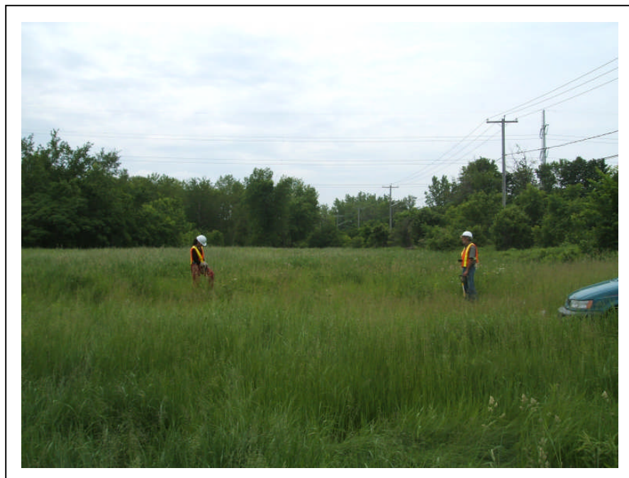
Photo 45 : (N.1-073) Projet MTQ 20-5100-8847, autoroute 25 : zone A, partie centrale, vu vers l'ouest
