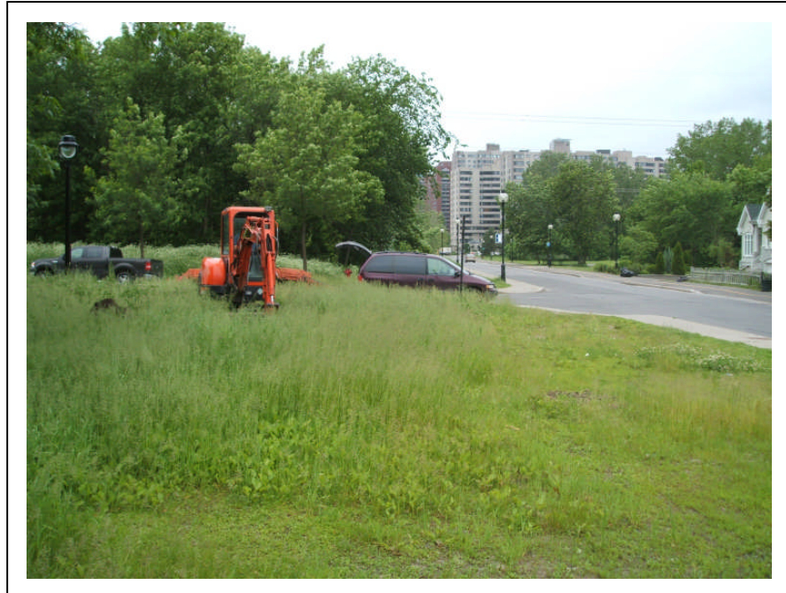
Photo 19 : (N.1-074) Projet MTQ 20-5100-8847, autoroute 25 : zone 17, excavation mécanique du sondage M-1, vu vers l'ouest
