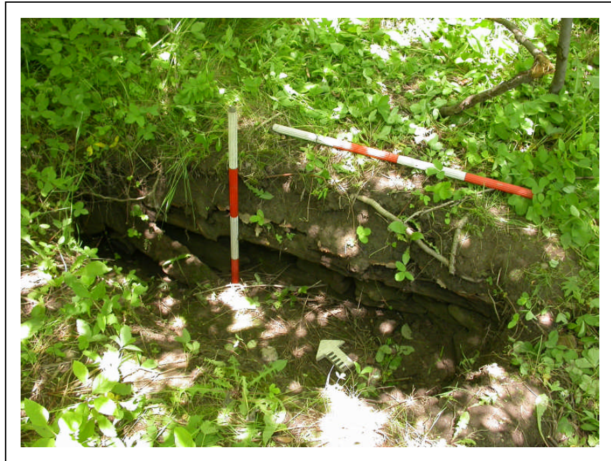
Photo 50 : (N.2A-023) Projet MTQ 20-5100-8847, autoroute 25 : zone A, réservoir d'eau vestige S7, sommet partiellement effondré, vu vers le nord-ouest
