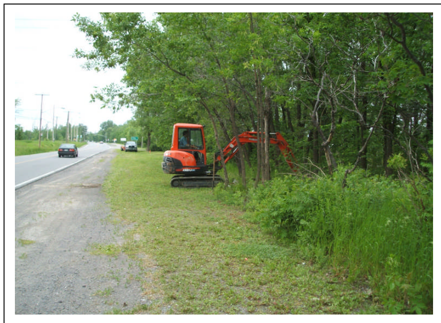
Photo 10 : (N.1-094) Projet MTQ 20-5100-8847, autoroute 25 : zone 14, excavation mécanique du sondage M-9, vu vers l'est
