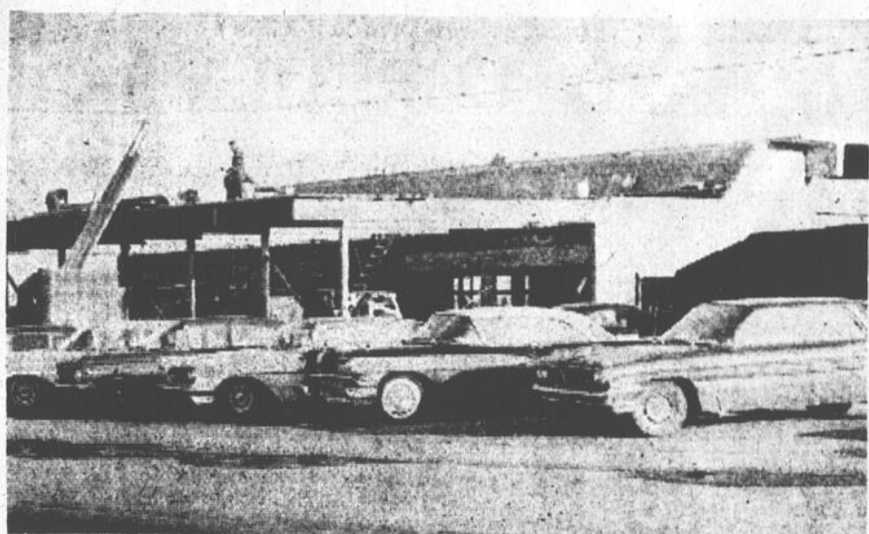
Les travaux de construction du garage Louiseville Automobile vont bon train. Le toit est construit de sept pièces de béton précontraint d'une pesanteur de 22,000 livres chacune. La pesanteur totale sur les fondations sera d'au-delà de 600,000 livres. L'équipement sera neuf et des plus modernes. Voici un aspect de cet édifice. Il y aura salle de montre, bureau, magasin et atelier. (Photo : Paul Deschesnes)
