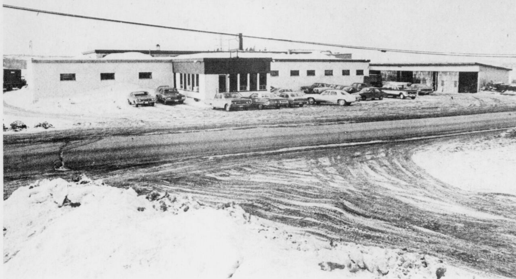
Vue d'ensemble de l'extérieur de l'usine.
