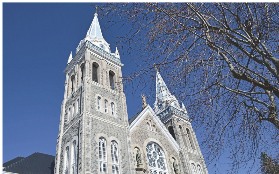
Farnham a fait appel à une firme d'architectes afin de l'accompagner dans sa démarche visant redéfinir les usages d'une partie de l'église catholique Saint-Romuald.
